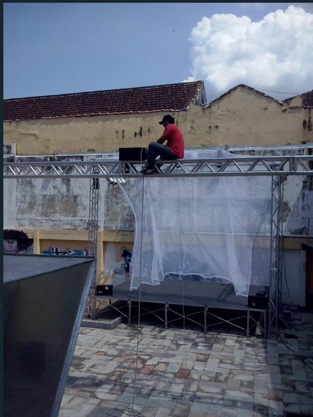
Foto : técnico instalando uma caixa de som acima do público, num espaço urbano. Manaus 14-08-15
